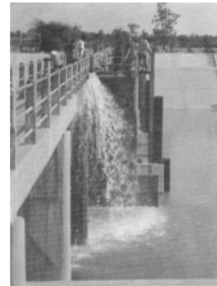
เขื่อนท่าวังหิน ที่บ้านบัว อ.พรรณานิคม จ.สกลนคร ที่ หลวงปู่ พาพระเถร และชาวบ้านทำการก่อสร้าง
